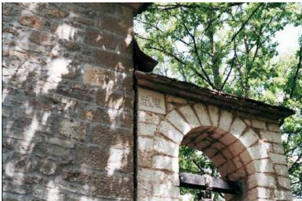
(Φωτ. 2): Λεπτομέρεια τοξολίθων στο κωδωνοστάσιο του Άι Θανάση που χτίστηκε το 1992. [Πηγή: Λήψη Θωμά Β. Ζιώγα, 2015].
