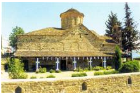
Εικόνα 4. Άποψη της νότιας πλευράς του ναού, όπου η κύρια είσοδος.
